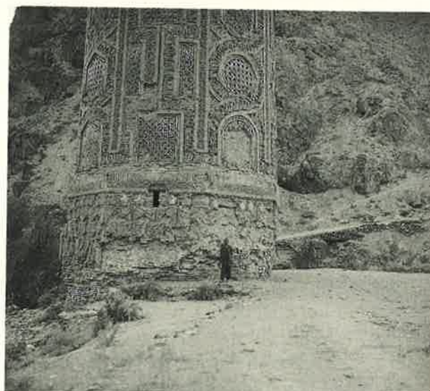
Fig. 3 og 4 Minareten i Jam i det centrale Ghor samt detaille af fundamentet.
